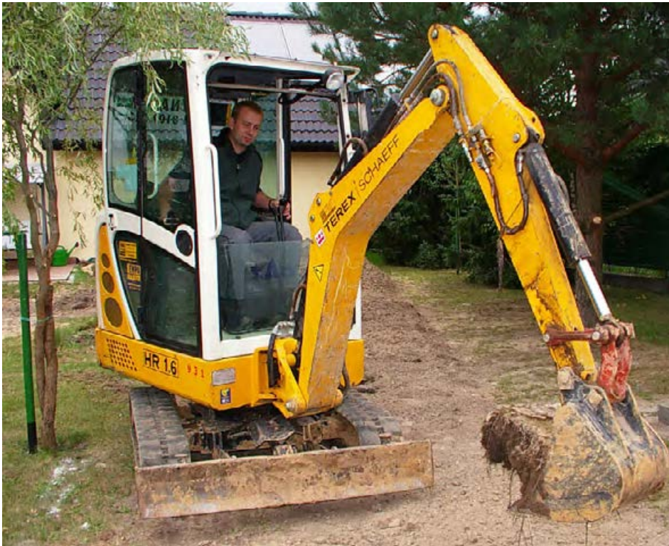
▲ Wykonanie dolnego źródła pompy ciepła (osobiście przez dr. Jarosława Dąbrowskiego)
